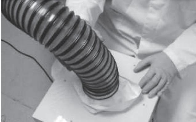
Con ayuda de un desatornillador de hoja plana, fijar una abrazadera alrededor del material de la manga y en la tubuladura de entrada del ventilador, para garantizar una posición segura del conducto de extracción y el material de la manga. Asegurarse de que la abrazadera esté firme.
