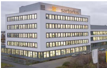
Göttingen, Deutschland Waagen-Fertigung modernisiert Erweiterung Spritzguss-Fertigung Logistikzentrum im Bau
