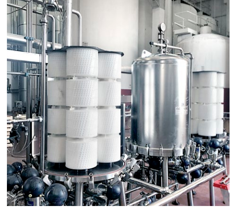
Caviro (Forlì): instalación de carcassas y cartuchos Jumbo Star en dos sistemas Cadalpe® para la estabilización tartárica continua de vino tinto y blanco. 2
